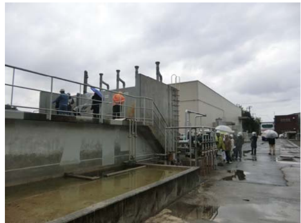
第 12 図 セパレーターと沈砂槽の見学風景。
