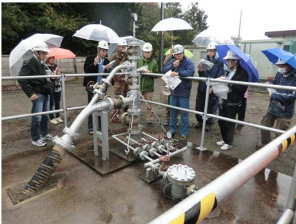
第 11 図 水溶性天然ガス生産井の見学風景。
